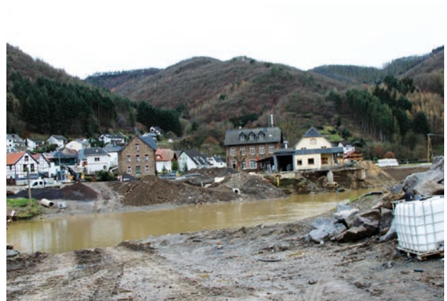
Auch heute sind noch viele Häuser unbewohnbar oder müssen, nach monatelanger harter Arbeit, jetzt doch noch abgerissen werden.
